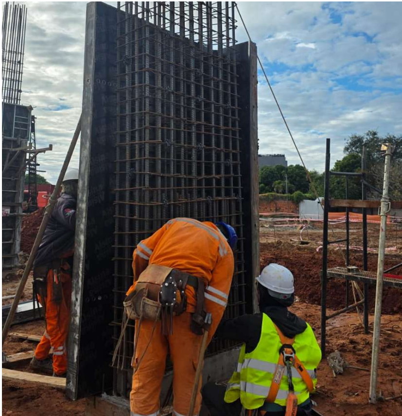
Trabajos de encofrado de pilares
