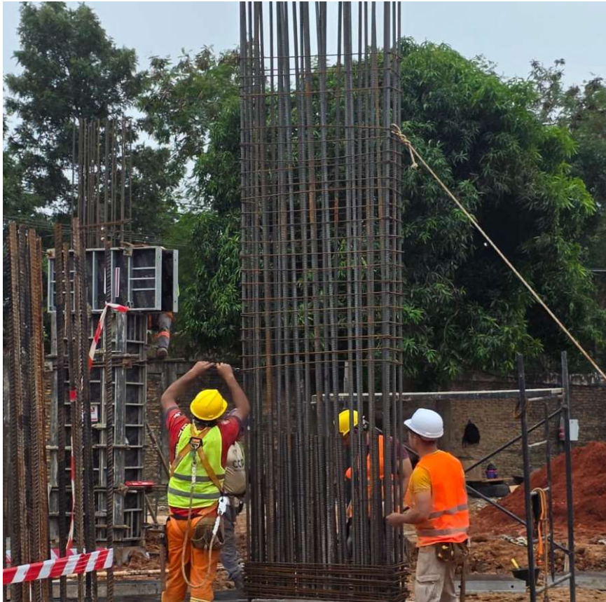
Trabajos de preparación de armaduras de pilares
